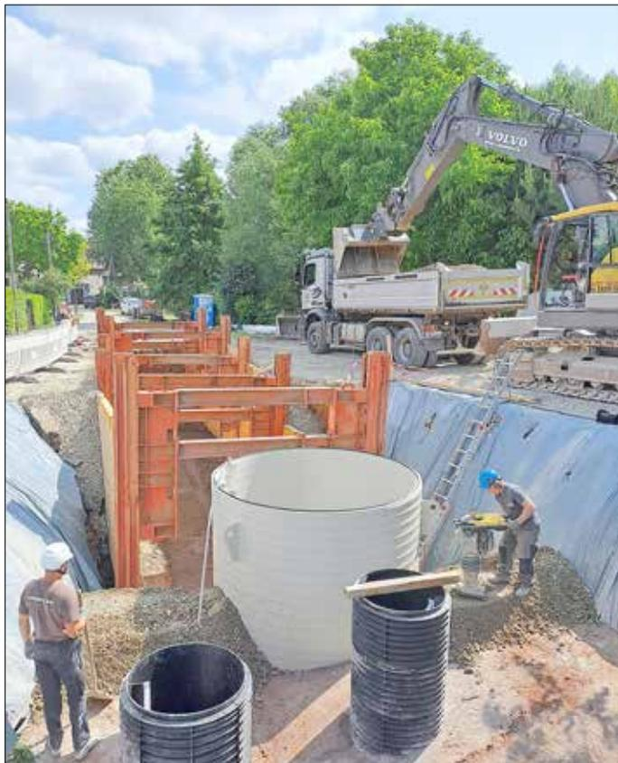
*Beeindruckender Tiefbau: Der neu entstehende Stauraumkanal kann bis zu 220 Kubikmeter Wasser fassen und schützt bei Starkregenergieereignissen vor Überschwemmungen.*
