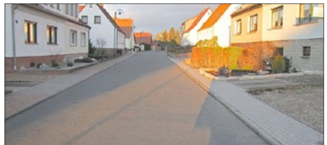
Fertigstellung und Abnahme der Bordsteinanlagen und Gehwegausbesserungen in der Siedlung Ortschaft Dingelstädt
