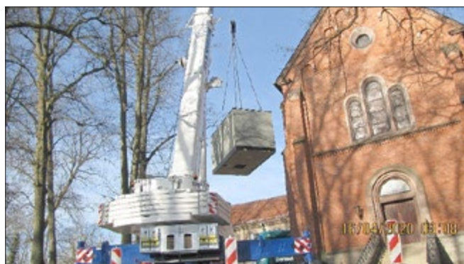
Am Kertschen Berg beginnen die Bauarbeiten mit dem Setzen der Toilettenanlage. Insgesamt wird der Bau der Toilettenanlage ca. 180.000 € kosten. Davon werden 93.000 € als LEADER-Projekt gefördert.
