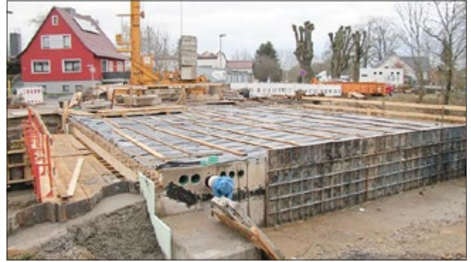
Unstrutbrücke - Rasenweg 02/2020 in der OS Dingelstädt
