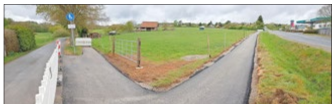
Der Verbindungsweg an der Heiligenstädter Straße wurde asphaltiert (OS Dingelstädt)
