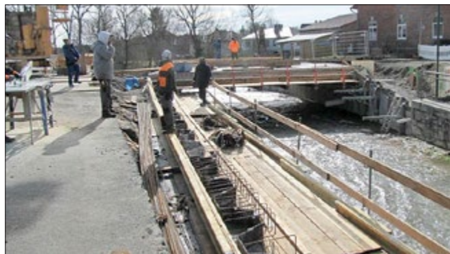
Aufbau der Ufermauer im Bereich der Grabenstraße (Foto vom 02.03.2020)
