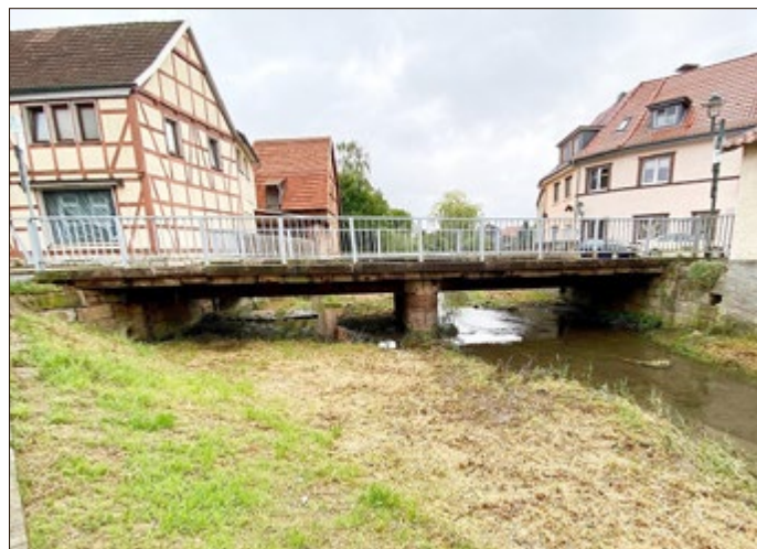
Brücke in der Brückenstraße (Ortschaft Dingelstädt)
