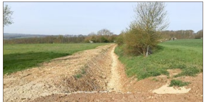
Regenrückhaltemaßnahme in Beberstedt „Graben Hellborn“
