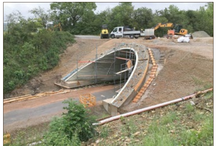
Bautenstand der Brücke über die Wachstedter Straße am 28.07.2023
