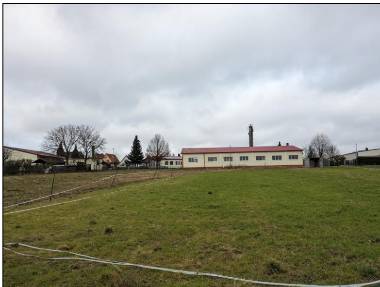
Abbildung 3: Blick über das Plangebiet von der südlichen Grenze des Geltungsbereiches
