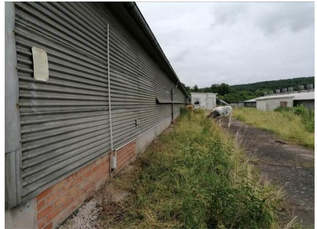
Abbildung 4 Fassadenverkleidung mit Wellblech an den Hallengebäuden, Foto: W+G 2022.
