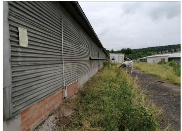
Abbildung 4 Fassadenverkleidung mit Wellblech an den Hallengebäuden, Foto: W+G 2022.
