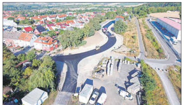
Am Dingelstädter Bahnhof wurden die Arbeiten beschleunigt. Bereits im September wurde der Asphalt eingebaut.
