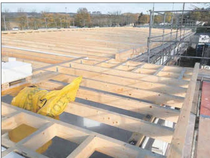
Auf dem Feuerwehrjugendzentrum & Multifunktionsgebäude in der Ortschaft Silberhausen wird der Dachstuhl errichtet.
