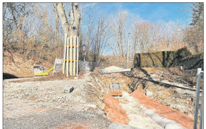
Erschließungsarbeiten an der Kefferhäuser Straße im Bereich der Zufahrt zum Kefferhäuser Bahnhof für das neue Baugebiet „Hinter dem Kerbschen Berg“.
