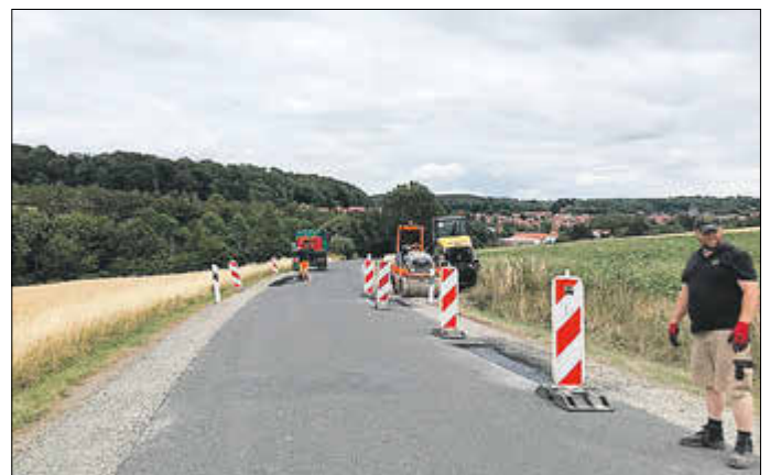
Erneuerung der Bankette an der Gemeindestraße zwischen Kreuzebra und Heuthen
