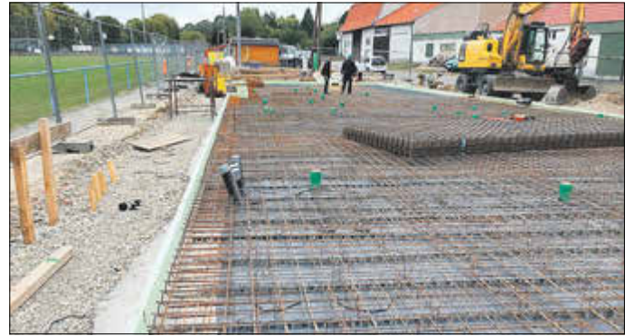
Die Bodenplatte ist bewehrt, der Fundamentanker eingebaut und die Kanalisation verlegt, nun kann Beton fließen.
