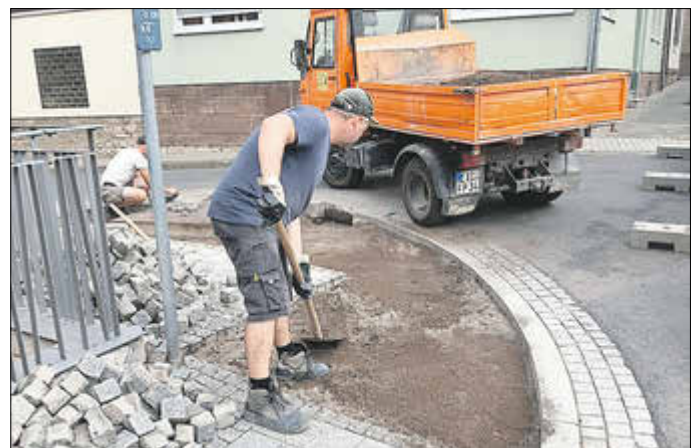
Sanierung der Gehweganlage in der Birkunger Straße Ecke Poststraße in der Ortschaft Dingelstädt
