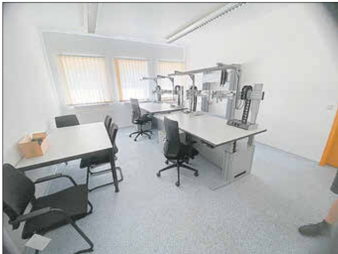
In der Stützpunktfeuerwehr der Ortschaft Dingelstädt wurde eine neue Leitstelle eingerichtet.
