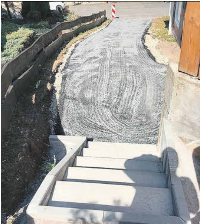
In Helmsdorf wurde der Fußweg zur evangelischen Kirche befestigt. Eine neue Treppenanlage wurde ebenfalls gebaut.
