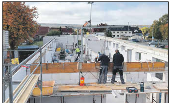
Nach der Betonage der Bodenplatte wurde zügig mit den Rohbauarbeiten begonnen.
