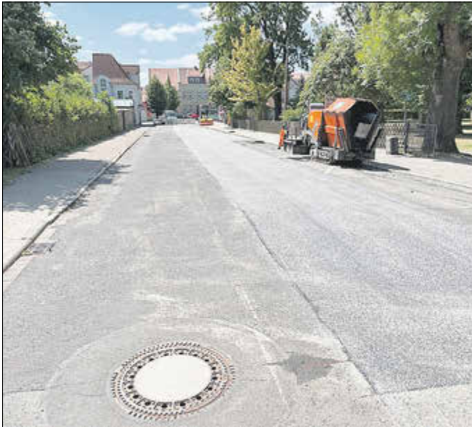
Sanierung der Straßendecke in der Marktsraße in der Ortschaft Dingelstädt
