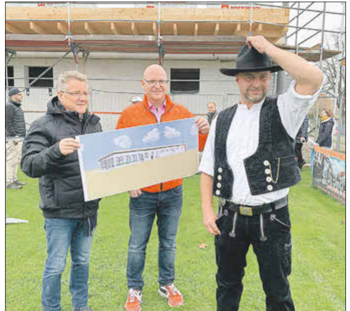
Am 18.11.2022 war es endlich soweit! In Silberhausen wurde Richtfest gefeiert. (v.l.n.r. Herbert Bochnig Architekt & Bauleiter, Michael Groß Ortschaftsbürgermeister Silberhausen, Richtmeister / Zimmererpolier Martin Winter sprach den Richtspruch)
