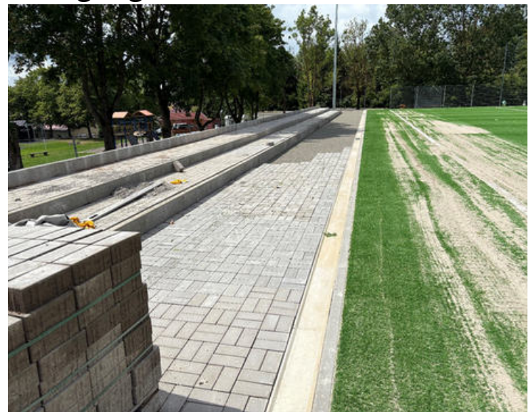
Bau der Tribünen und Einbau des Saharasesandes als Lastmaterial im Kunstrasen
