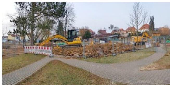
Im Januar wurde mit umfangreichen Kanalarbeiten am Kindergarten „BUMMI“ begonnen. Die Regenwasser- und Abwasserleitungen waren marode. Sie stammten noch aus den 1980er - Jahren. Im März konnten die Arbeiten abgeschlossen werden. Die Dimensionierung der Regenwasserrohrleitungen wurde größer als erforderlich ausgeführt. Somit sollten Überflutungen der Kellergeschosse (wie im Jahr 2020) für die Zukunft möglichst ausgeschlossen werden.
