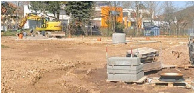
Im Baugebiet an der Steinstraße werden die Arbeiten wieder aufgenommen. Zunächst werden die neu verlegten Regenwasserleitungen und Abwasserleitung neu an des bestehende Netz bzw. dem Siechengraben angeschlossen. Bis zum Jahresende sollen vier der fünf geplanten Häuser bereits stehen. Fertigstellung der gesamten Maßnahme ist für Ende 2022 geplant.
