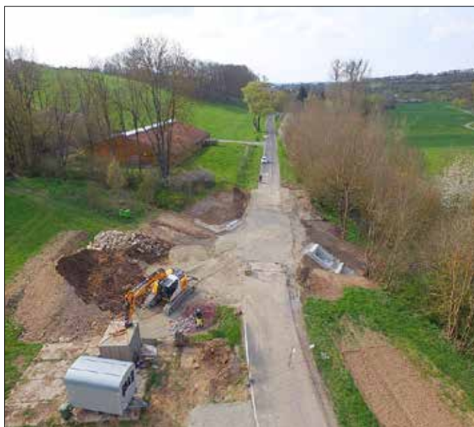
Drohnenaufnahme der Bauarbeiten
