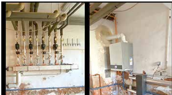
Einbau einer neuen Heizungsanlage in der Ambulanz, Ortschaft Dingelstädt
