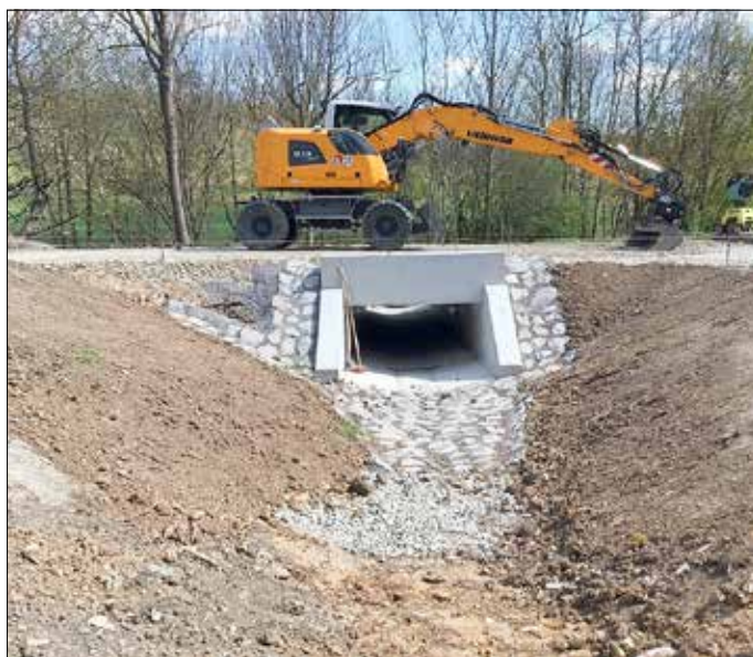
Vorbereitung für die Asphaltarbeiten
