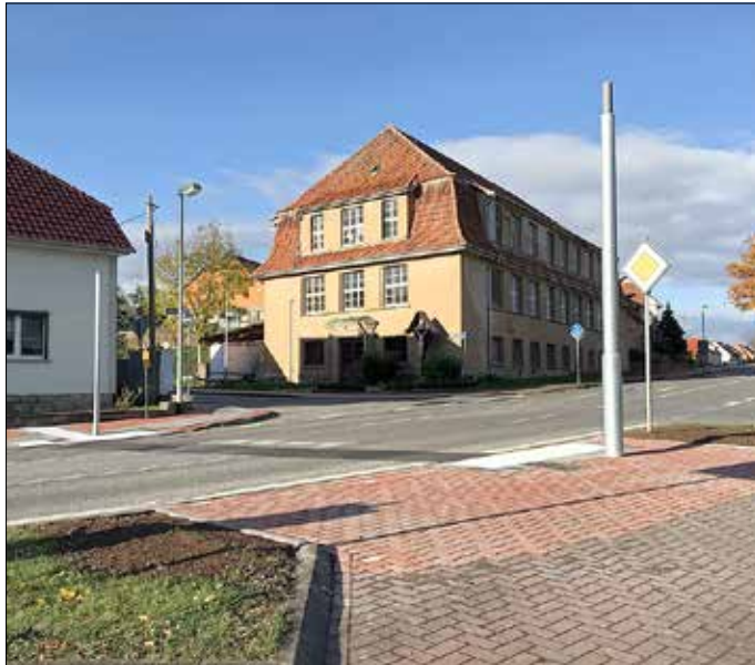
Neubau Fußgängerampel in Bickenriede
