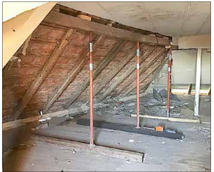
Notsicherung der Dachkonstruktion im ehemaligen EOW-Gebäude in Kefferhausen
