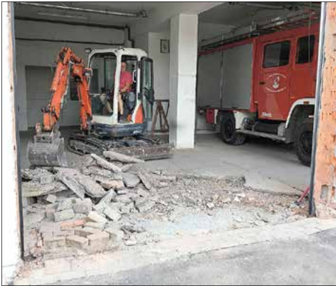
Rückbau Fußboden
