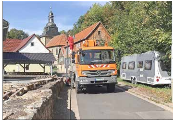
Montagearbeiten der LED Straßenbeleuchtung
