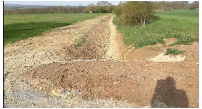
Grabennivelierung entlang dem alten Bahndamm Beberstedt Richtung L2043
