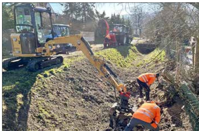
Instandsetzung des Grabens in Bickenriede
