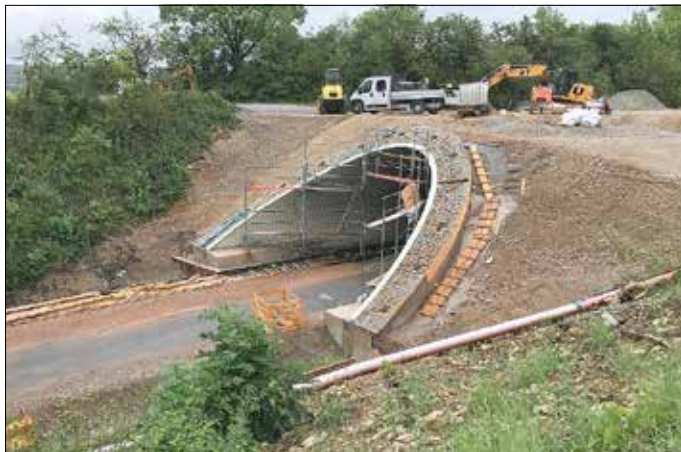
Arbeiten am Oberbau der Brücke
