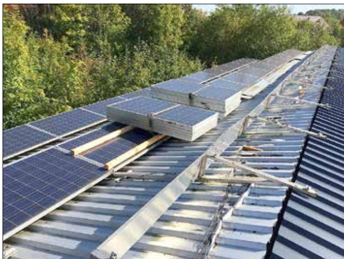
Wiedermontage PV-Anlage
