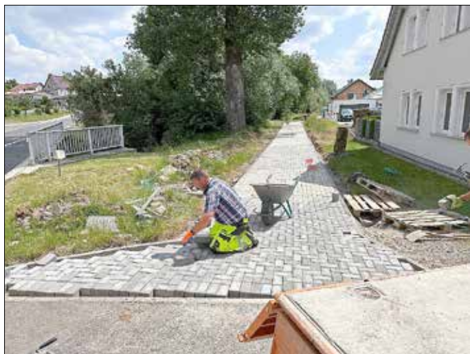
Gehweganlage in der Ortschaft Kefferhausen
