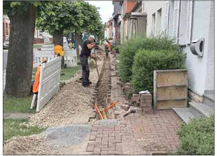
Ausbau in der Bahnhofstraße OS Dingelstädt 2023 Foto: A. Fernkorn
