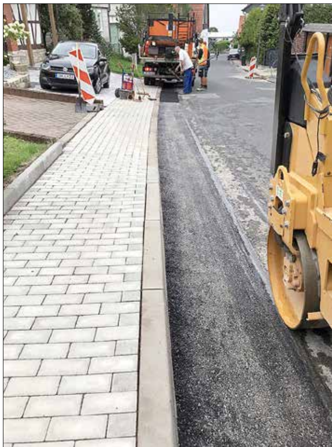
Gehweganlage „Ländchen“: Hier bauten die Anlieger den Gehweg und die Firma Weber erledigte die Asphaltarbeiten. Ein herzliches Dankeschön an alle Anwohner für Ihre Eigenleistung.
