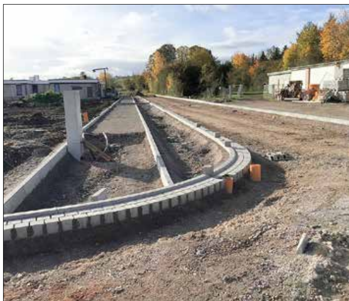
Bordanlagen des Wohnbaugebietes „Am Lohberg I“
