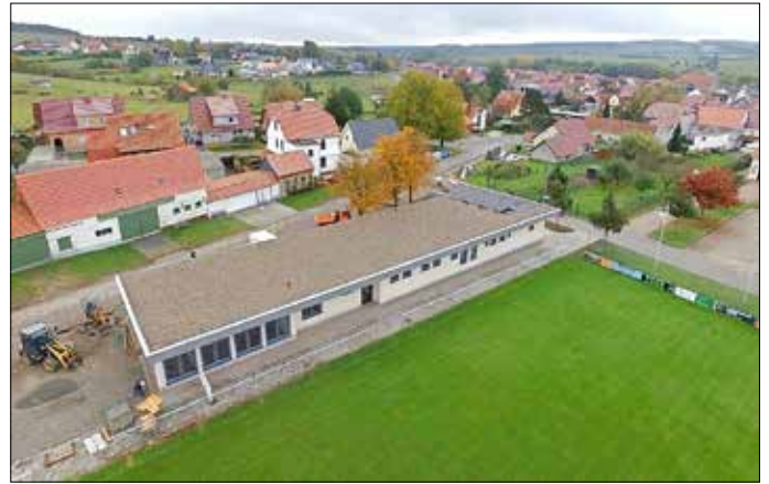
Drohnenaufnahme nach Fertigstellung Gebäude
