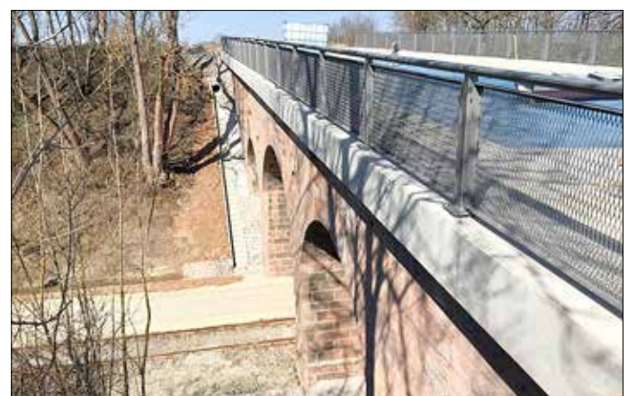
Ausbesserung des Natursteinmauerwerkes
