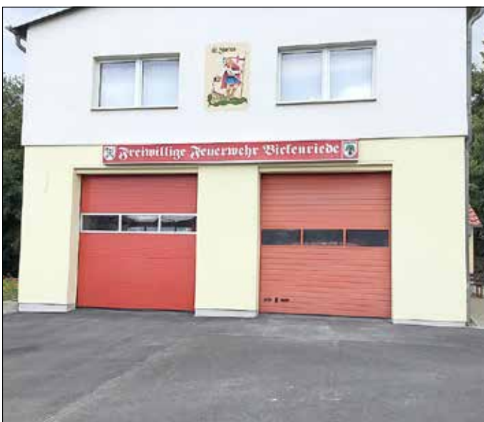
Fertigstellung der Toranlage und Sanierung des Zufahrtbereichs
