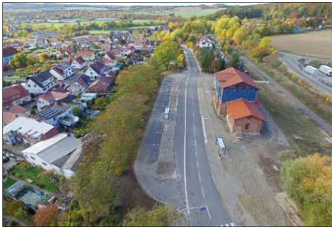
Drohnenaufnahme Fertigstellung Straße am Bahnhof inkl. Parkflächen und E-Lade Stationen
