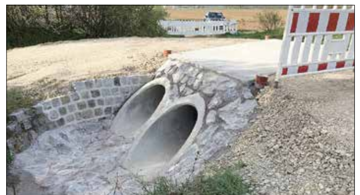
Feldwegüberfahrt 2x DN 500 zur Aufnahme der Witterungsniederschläge
