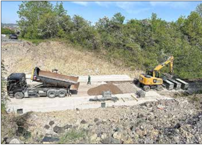
Fundamentherstellung
