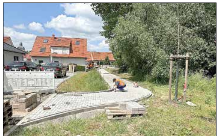
Pflasterarbeiten durch den Bauhof ausgeführt
