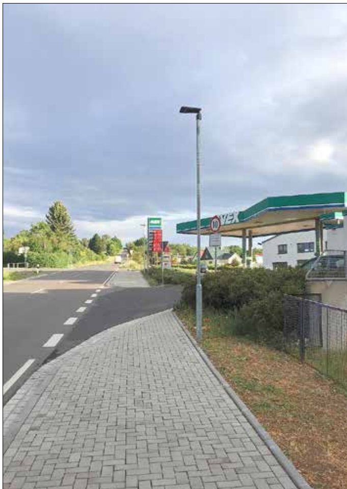
Fertigstellung der Gehweganlage Heiligenstädter Straße 2023
