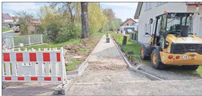
Einbau des Schotterplanums als Tragschicht für das Pflaster
