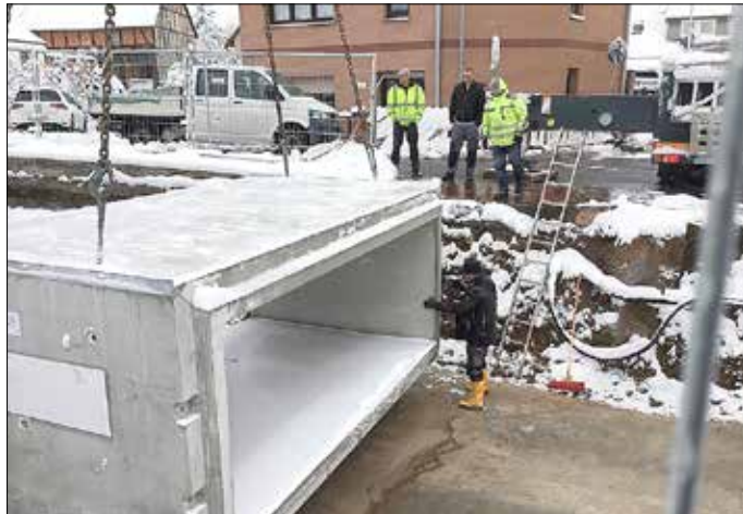
Am 28.11.2023 wurden die Fertigteile der neuen Brücke gesetzt.
