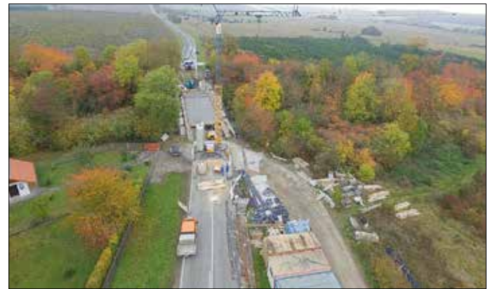
Drohnenaufnahme der laufenden Bauarbeiten
