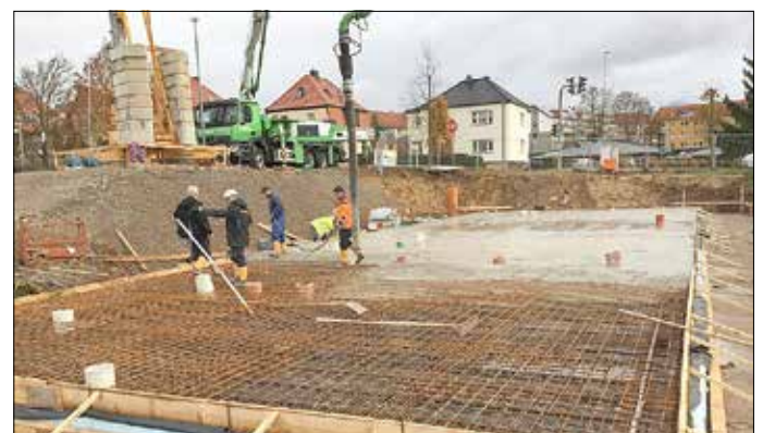
Am Montag dem 13.11.2023 wurde die Bodenplatte betoniert
