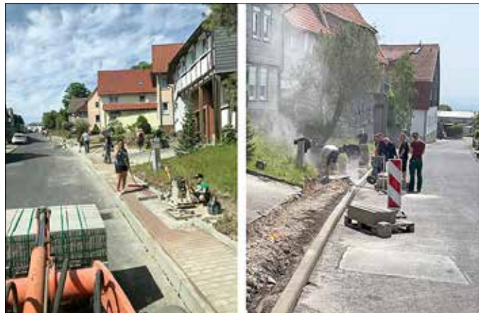
Neubau der Gehweganlage „Ländchen“ in der Ortschaft Beberstedt
