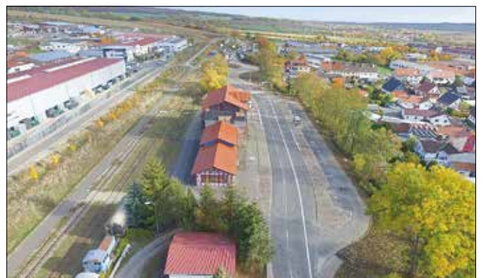
Drohenaufnahme Fertigstellung Straße am Bahnhof inkl. Parkflächen und E-Lade Stationen
