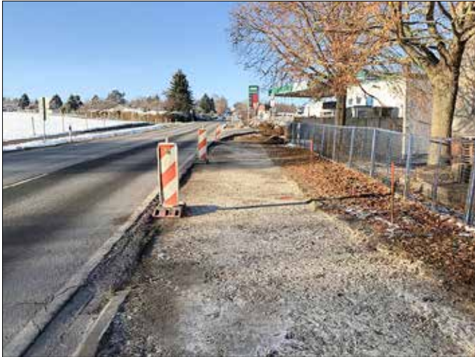
Ausbau der Gehweganlage Heiligenstädter Straße im Januar 2023
