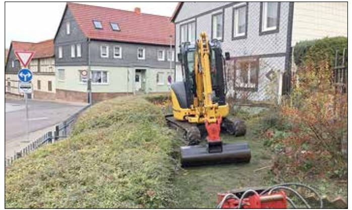
Rodungsarbeiten durch den Bauhof
