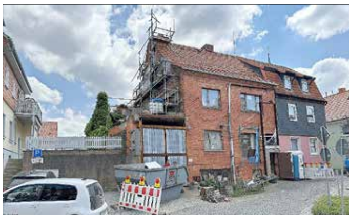
Beginn der Abrissarbeiten
