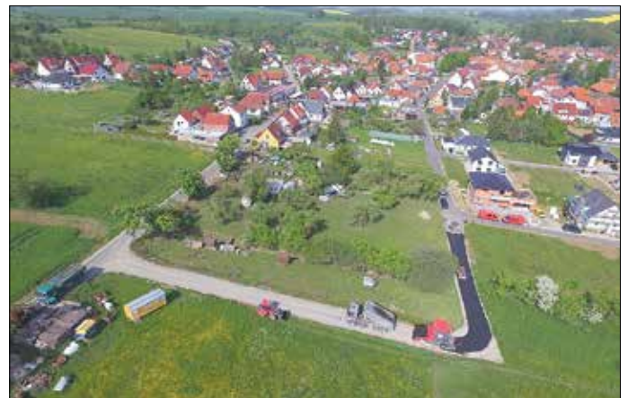
Drohnenaufnahme Asphaltarbeiten an der Baustellenumfahrung
