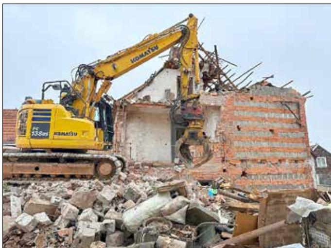
Fortführung der Abrissarbeiten
