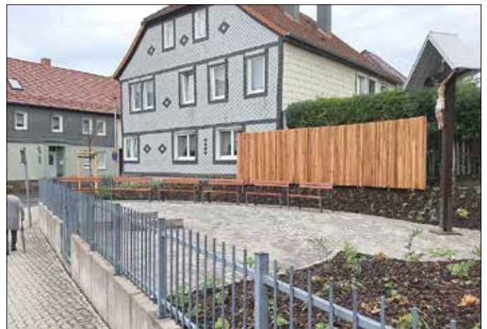
Fertigstellung der Parkanlage „Vor dem Kerftor“
