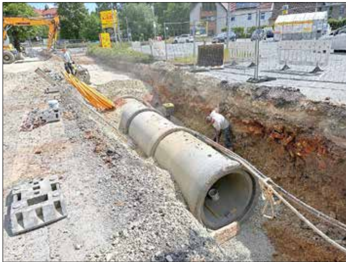
Ausbau der Straße und des Schützenplatzes mit einem 370 m 3 fassenden Regenwasserstaukanal
