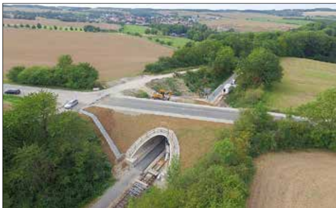
Drohnenaufnahme kurz vor Fertigstellung
