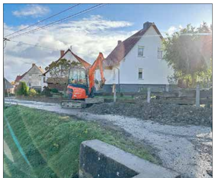
Glasfaserausbau in der Neuen Straße in Kefferhausen
