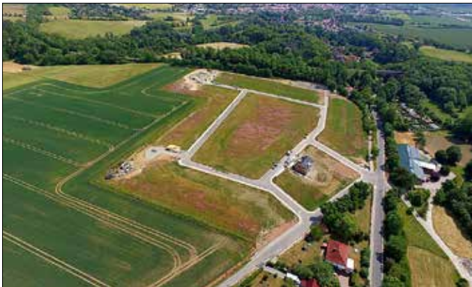
Wohnbaugebiet „Zum Kirchberg“ für 43 Bauplätze erschlossen
