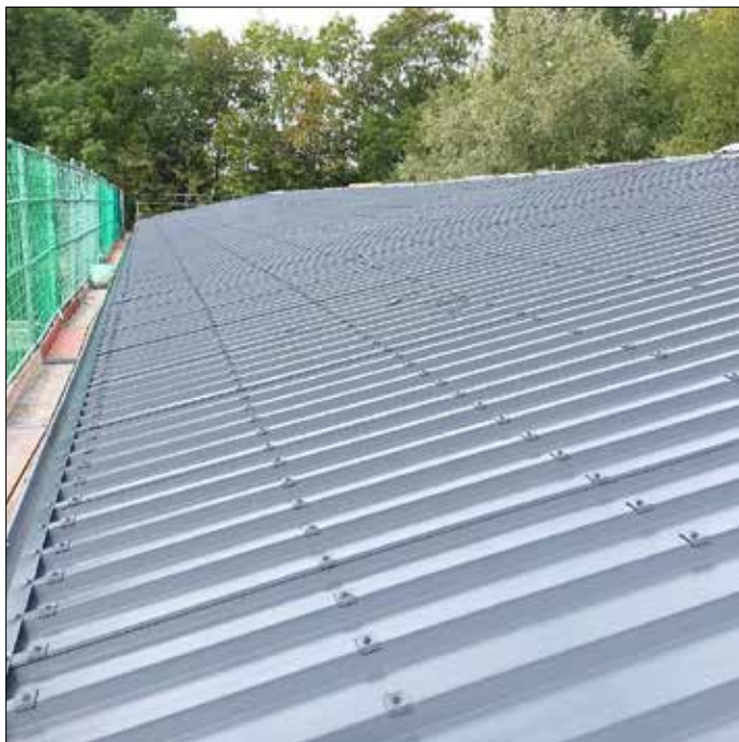
Saniertes Dach Bauhof Bickenriede
