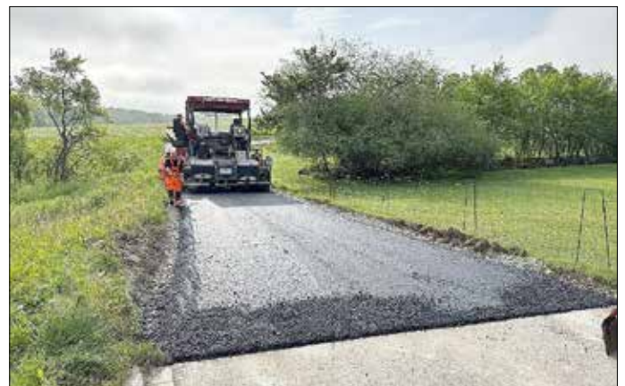
Asphaltarbeiten an der Baustellenumfahrung
