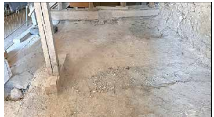
Freigelegter Fußboden durch die Mühlhäuser Jugendbauhütte
