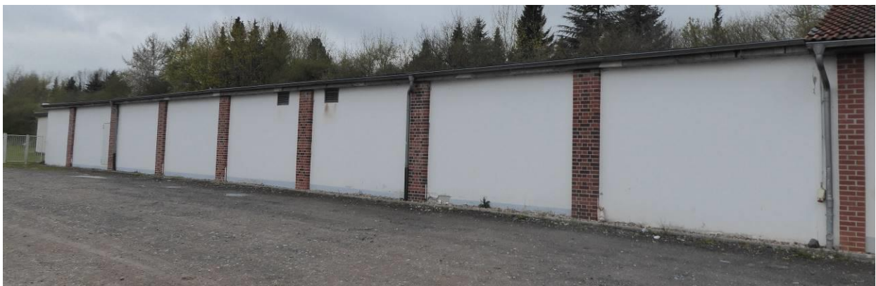
Ansicht 25 Meter Schießanlage mit Tür und Lüftungsöffnungen
